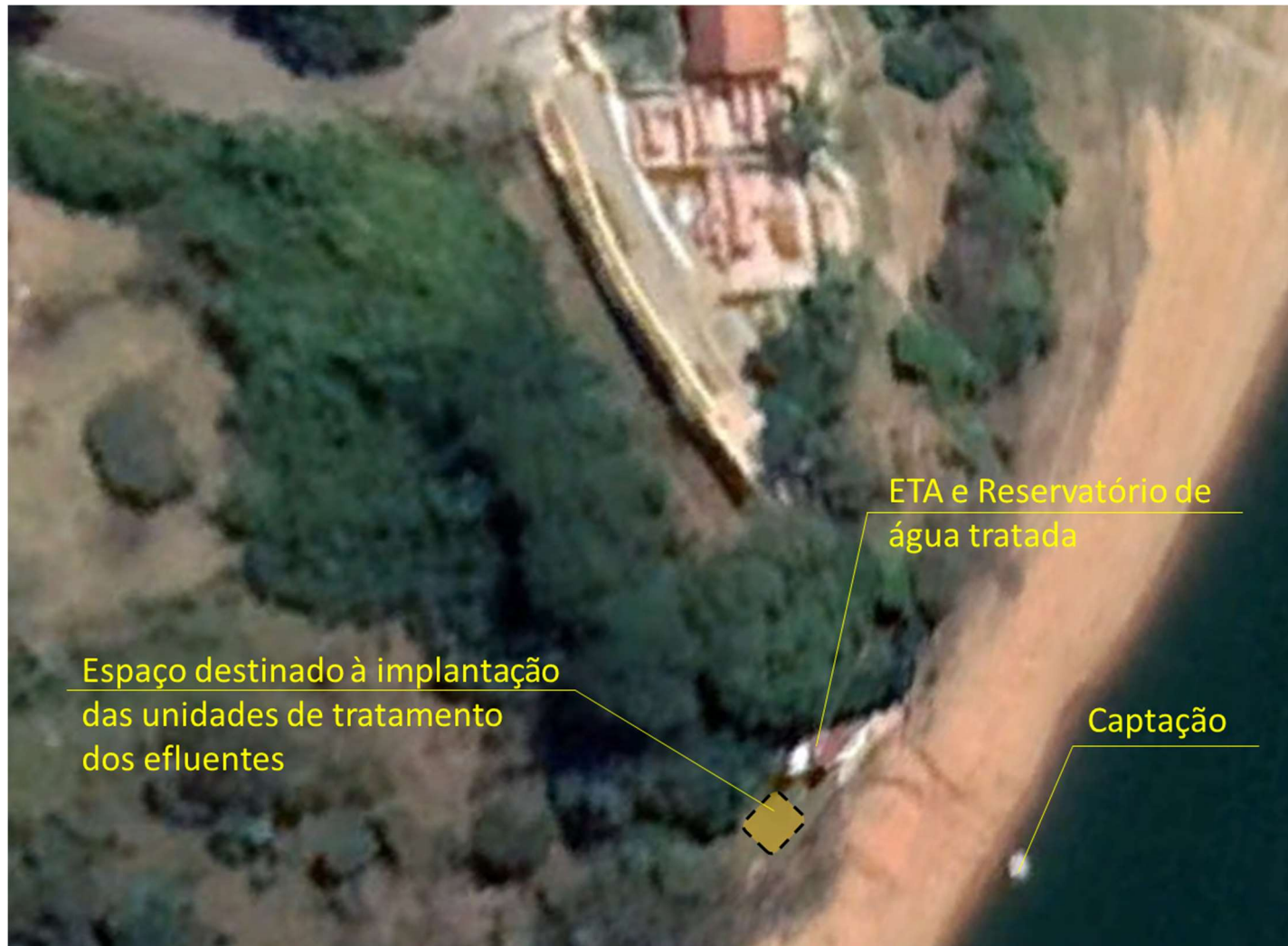
Figura 16 ETA I Possível local de implantação do sistema de tratamento dos efluentes
